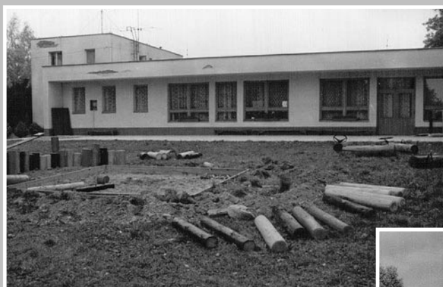
◀◀◀ Budování dětského pískoviště u MŠ Louňovice v roce 1986
