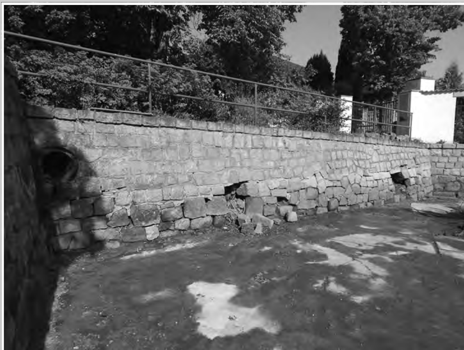
NÁVESNÍ RYBNÍČEK, STAV PŘED OPRAVOU
