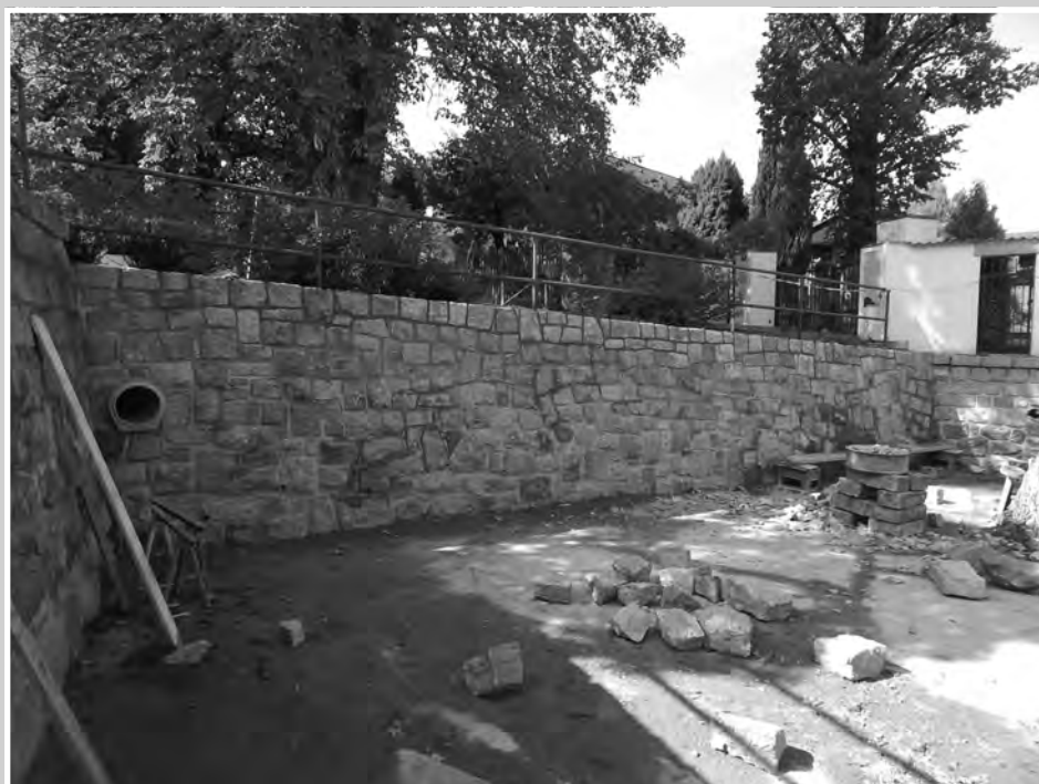
NÁVESNÍ RYBNÍČEK, STAV PO OPRAVĚ, NENÍ DOKONČENO
