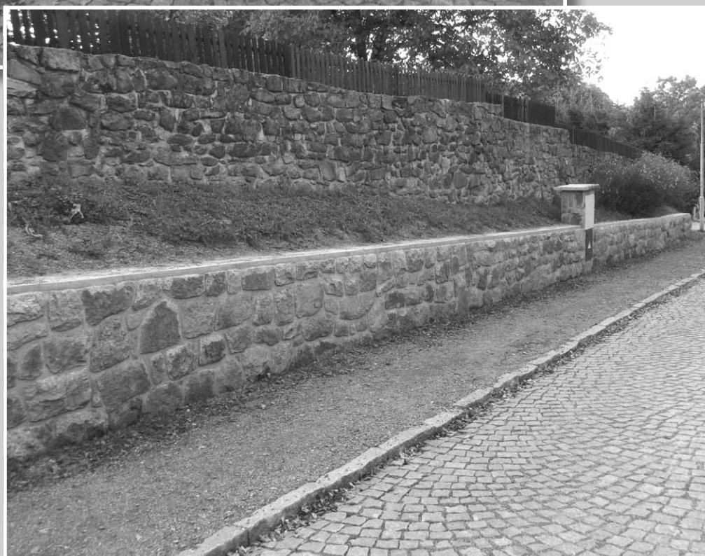
LETOŠNÍ OPRAVA TARASU NA ZVONIČCE SPOJENÁ S ROZŠÍŘENÍM CHODNÍKU
